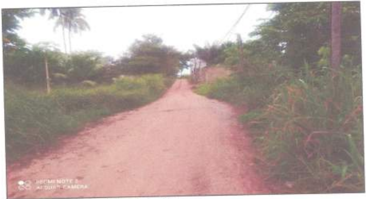
Foto 01 – Rua da Pedreira – Bairro Cabanos
